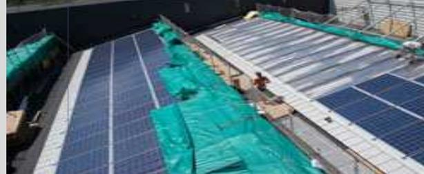
Sur le toit du hall de conditionnement, une toiture en shed sert de support à des panneaux photovoltaïques cristallins orientés plein sud. Les 400 m<sup>2</sup> permettent de fournir jusqu'à 54,12 kWc (kWc) Sur la zone plane de la toiture stockage, 1150 m<sup>2</sup> de membranes photovoltaïques ont été mises en place et peuvent produire jusqu'à 50,4 kWc
