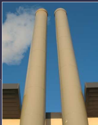
Conduits de fumée
